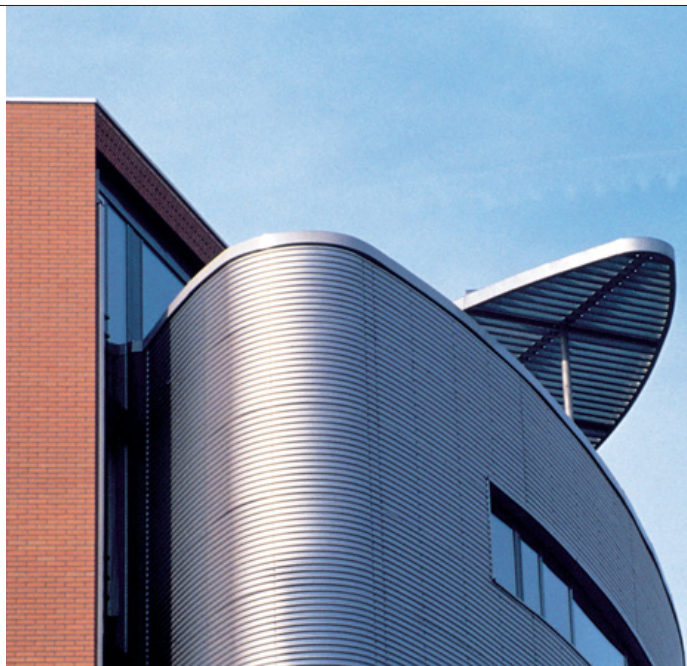
Immeuble de bureaux Remo-Invest, Bruxelles Profil ondulé Aluform 18/76
